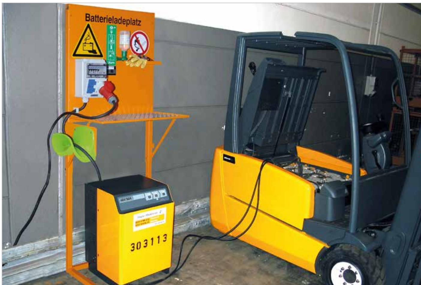
BL avec extincteur et prise de courant norme CEE 400 V et chariot élévateur en court de charge
