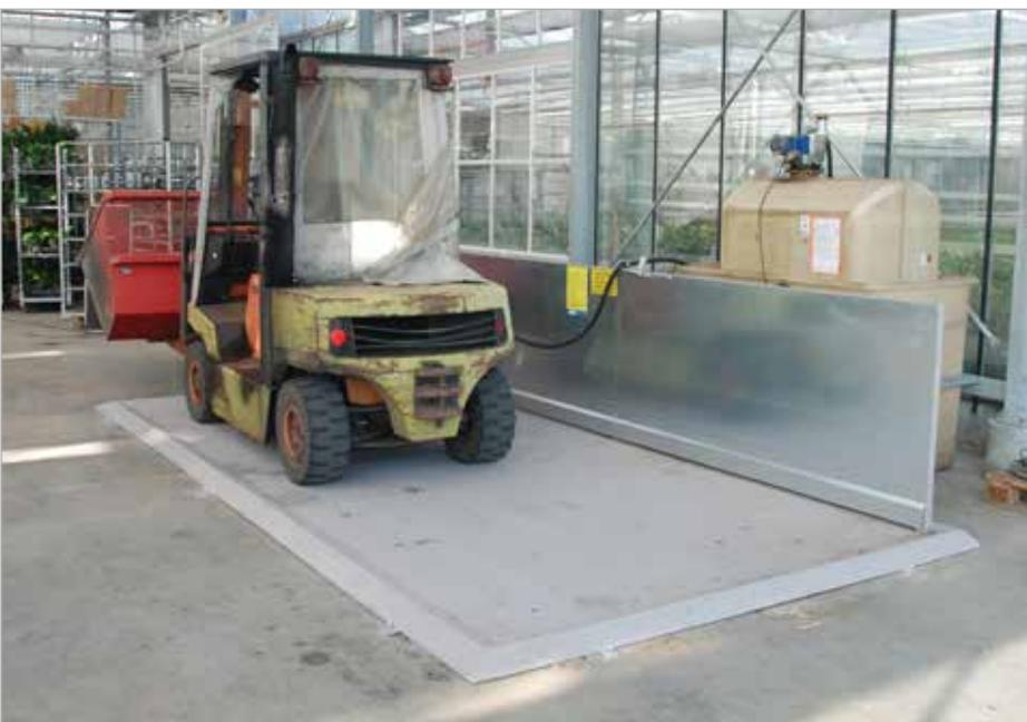
Plateforme d'approvisionnement pour Diesel et Biodiesel, à usage propre, pour un positionnement en intérieur et sous toiture
